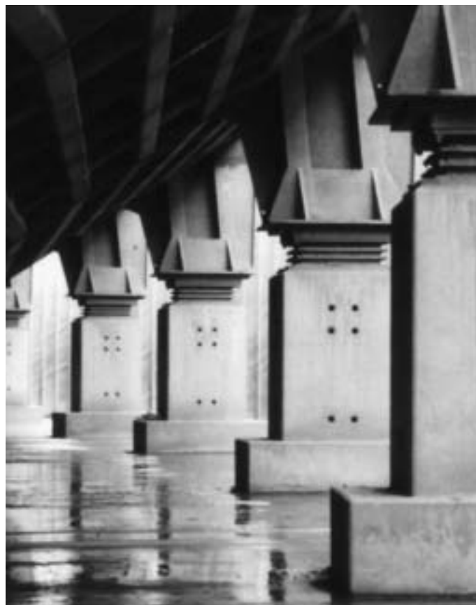
Bearings sector door 'Maeslantkering' (see p.15)
